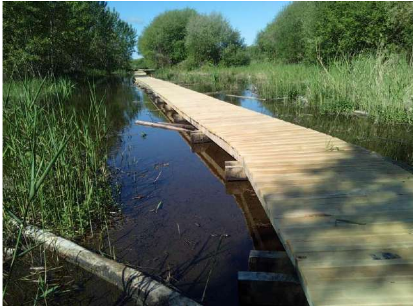
Figure 33 : platelage du sentier de découverte sur la partie nord (photo PNRLAT).
