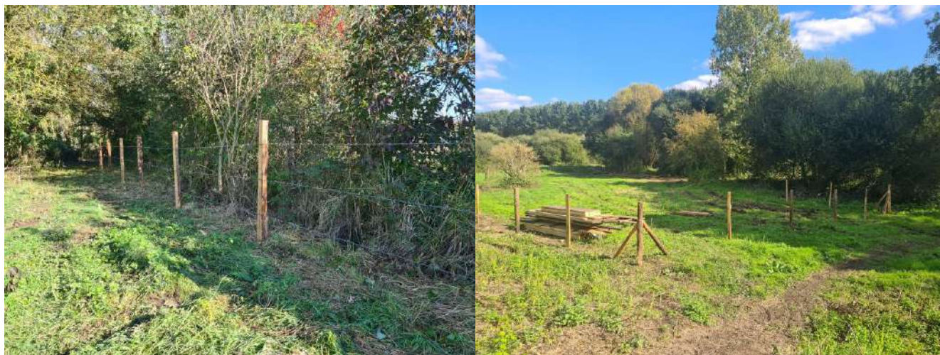
Figure 20 : Pose de la nouvelle clôture (photos CC CVL).
