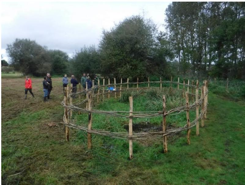
Figure 26: Chantier bénévole pour la réalisation d'une protection de mare (octobre 2022, photo CPIE TVDL)
