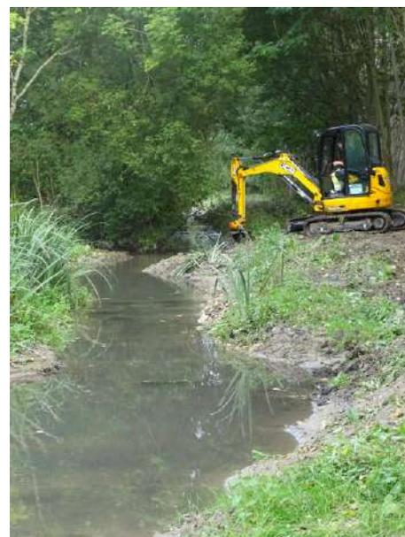
Figure 5: Opération de désensablement des radiers (photo PNR LAT)
