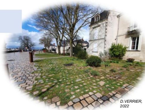
Pavés avec joints perméables, Angers (49)
