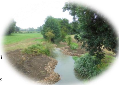
Travaux restauration de lit, installation banquettes, radiers (Syndicat de rivières Val de Vienne)
