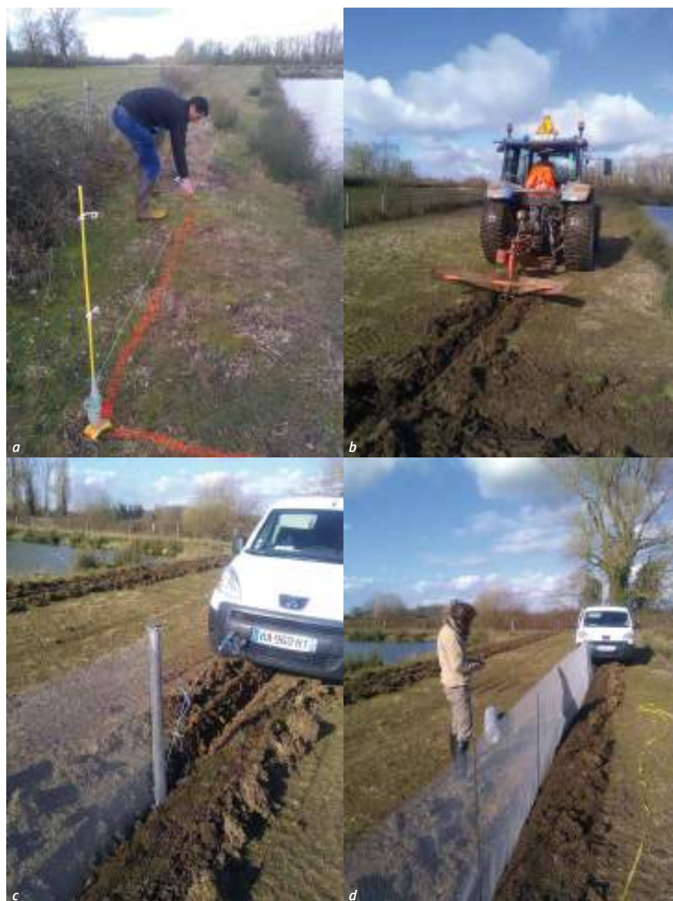
Figures 113a, 113b, 113c, 113d. Préparation de la tranchée et pose du grillage. Photos ©CCT
