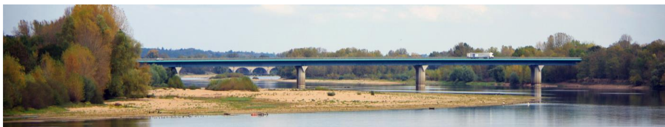
Pont autoroutier en béton franchissant la Loire à Langeais
