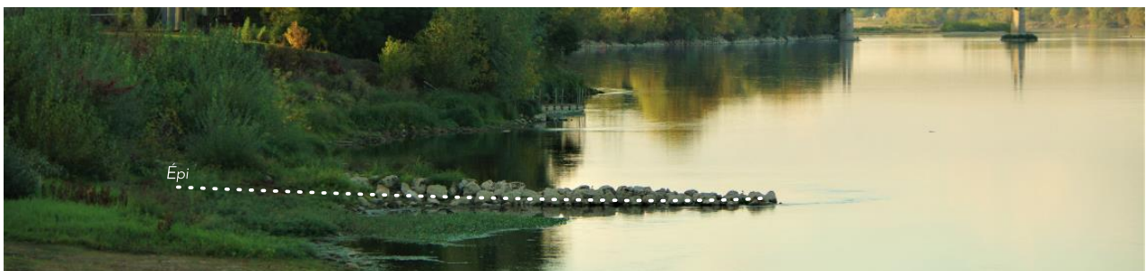
Un épi de taille réduite implanté perpendiculaire à la berge (Montsoreau)
