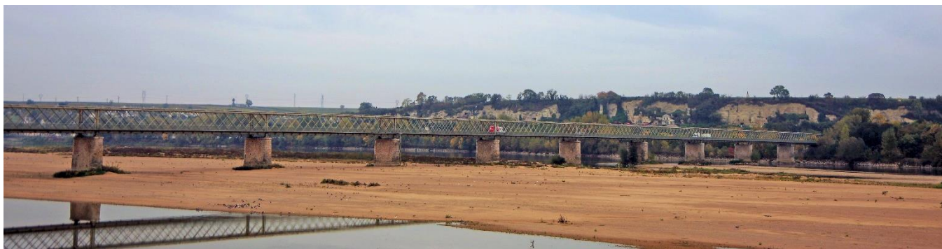
Pont métallique de Montsoreau
