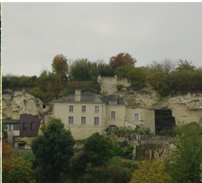
Une ancienne cavité partiellement utilisée pour l'habitat (à droite, la profondeur de la cavité peut être appréciée)
