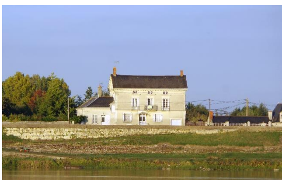
Des habitations établies sur la Grande levée d'Anjou (Varennes-sur-Loire)
