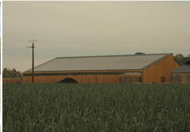
A.1.2. Développement de dispositifs liés aux énergies renouvelables (Villebernier)
