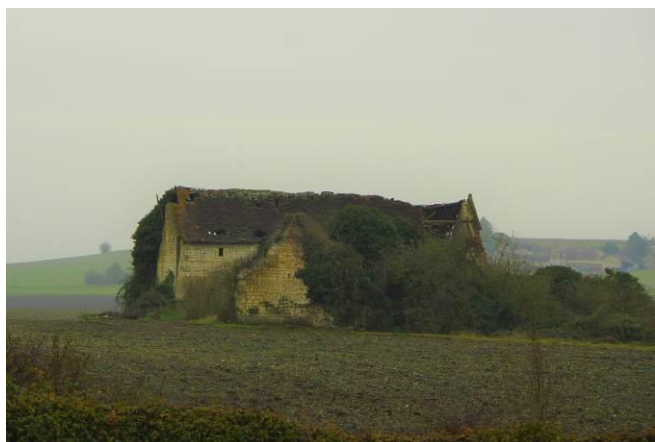
B.3. Dégradation, abandon ou reconversion du petit patrimoine bâti (Verneuil-le-Château)
