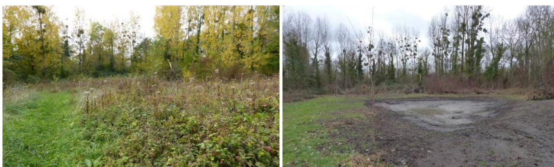
Création d'une mare, chantier du Contrat nature de Beaufort-en-Vallée
