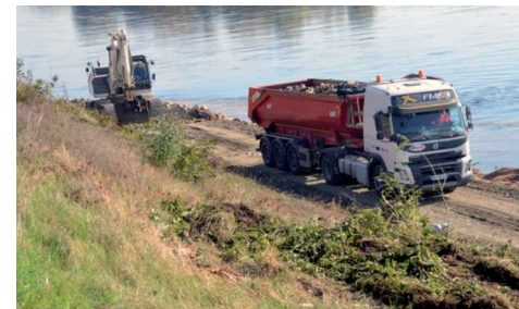
Travaux de renforcement de la levée du Val d'Authion à la Chapelle-sur-Loire (2017) Source : La Nouvelle République du Centre-Ouest
