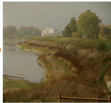
La Chapelle-sur-Loire : aménagement d'un chemin piétonnier
