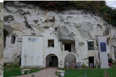
Reconversion d'une carrière de tuffeau pour le tourisme et le loisir, nécessitant un renforcement des espaces techniques supports (stationnement notamment) - Turquant
