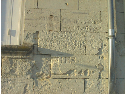
Mairie de Chouzé-sur-Loire et son échelle des crues
