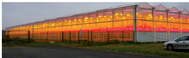
Serres éclairées du Parc d'activité du Véron
