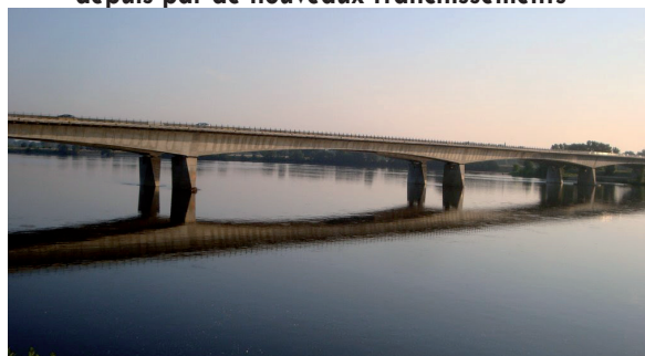
Pont du Cadre Noir à Saumur après son doublement
