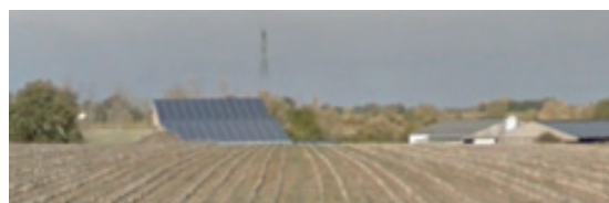
Bâtiment agricole avec une couverture photovoltaïque à Brigné-sur-Layon
