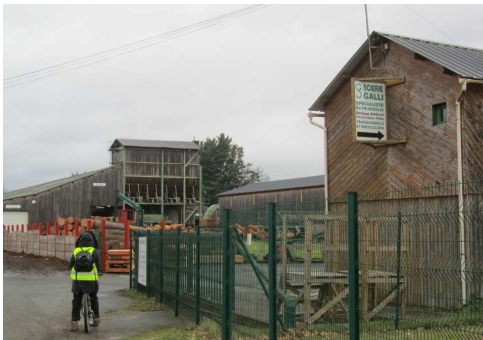
Figure 32 : Photographie de la scierie d'Allonnes. Donnat, R. 2021
