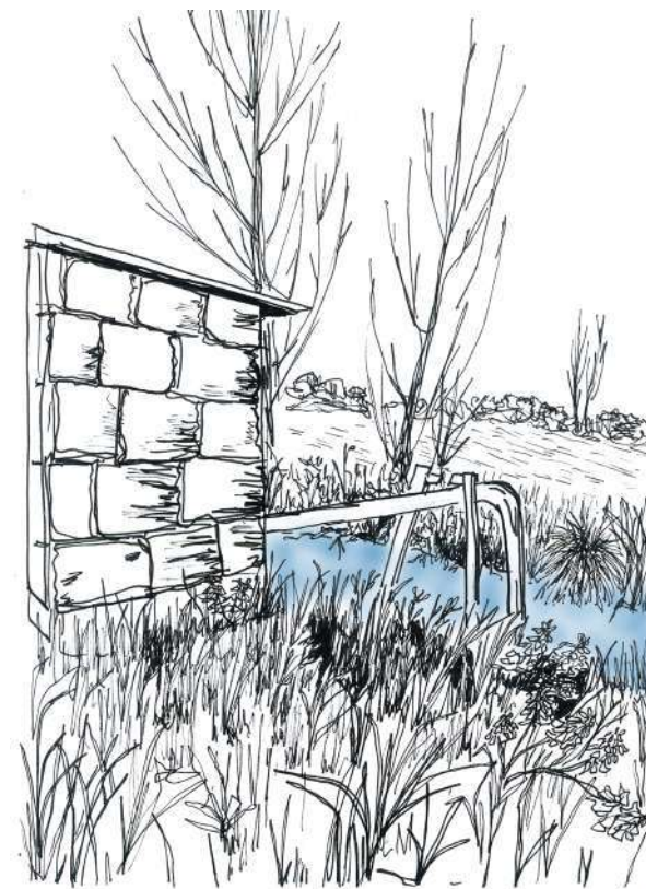
Figure 19b : Station de pompage, commune de Brain-sur-Allonnes. Petit, A. 2021
