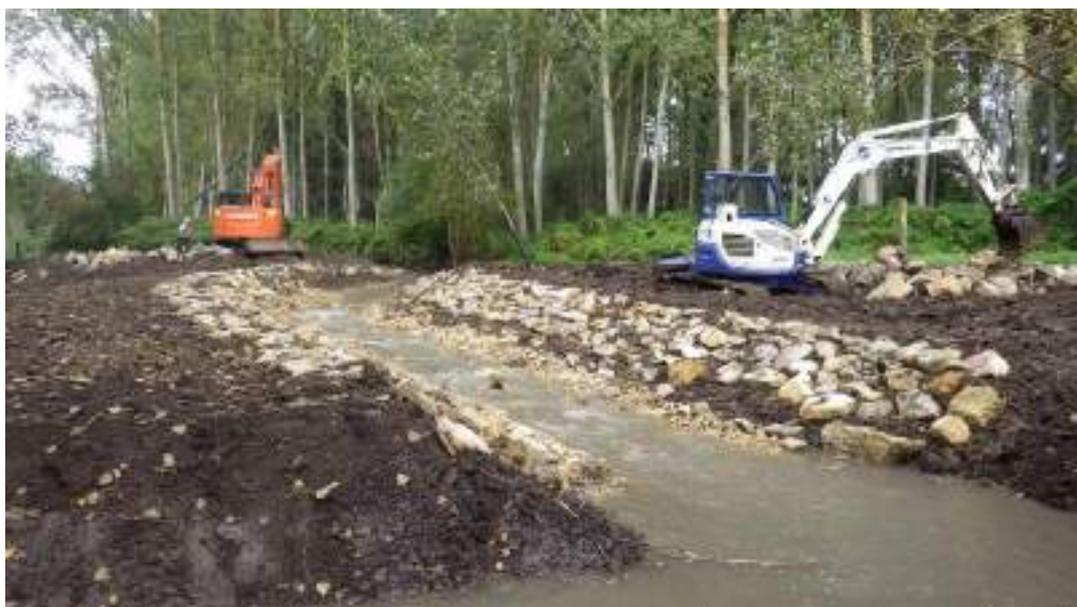
Figure 3: Arasement de l'ancienne surverse amont en béton et aménagement d'une rampe en enrochement (photo PNRLAT)
