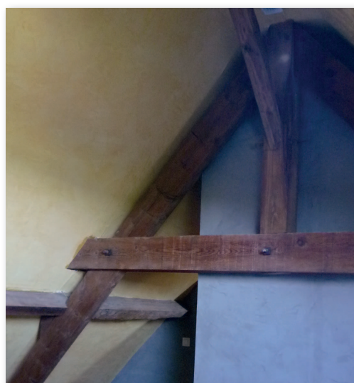
Enduit façon tadelakt : chaux, pigments naturels et poudre de marbre
