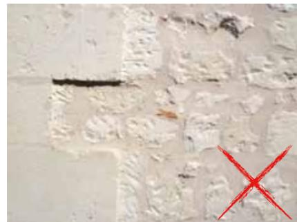
Ici, l'enduit couvrait initialement les moellons. Le rejointoiement n'est donc pas adapté puisqu'on retrouve les traces de piquage et la surépaisseur des pierres de taille de la chaîne d'angle.
