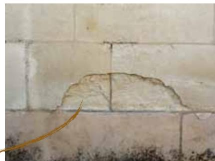
**Les autres pierres** : lorsque le tuffeau est en contact avec une pierre plus dure, **la roche la plus tendre se dégrade plus rapidement à cause de la rétention d'eau.** C'est pourquoi au XIXe siècle, on retrouve une brique entre le tuffeau et les pierres froides du soubassement. La perméabilité de la brique favorise l'évaporation de l'eau et évite la stagnation de l'humidité dans le tuffeau.
