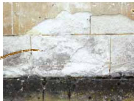
Lorsqu'il est saturé en eau, le tuffeau perd 30 % de sa résistance à la compression. Soumise à des charges importantes, la pierre trempée se fracture. Enfin, en hiver, la pierre peut éclater par la répétition des cycles gel/dégel.
