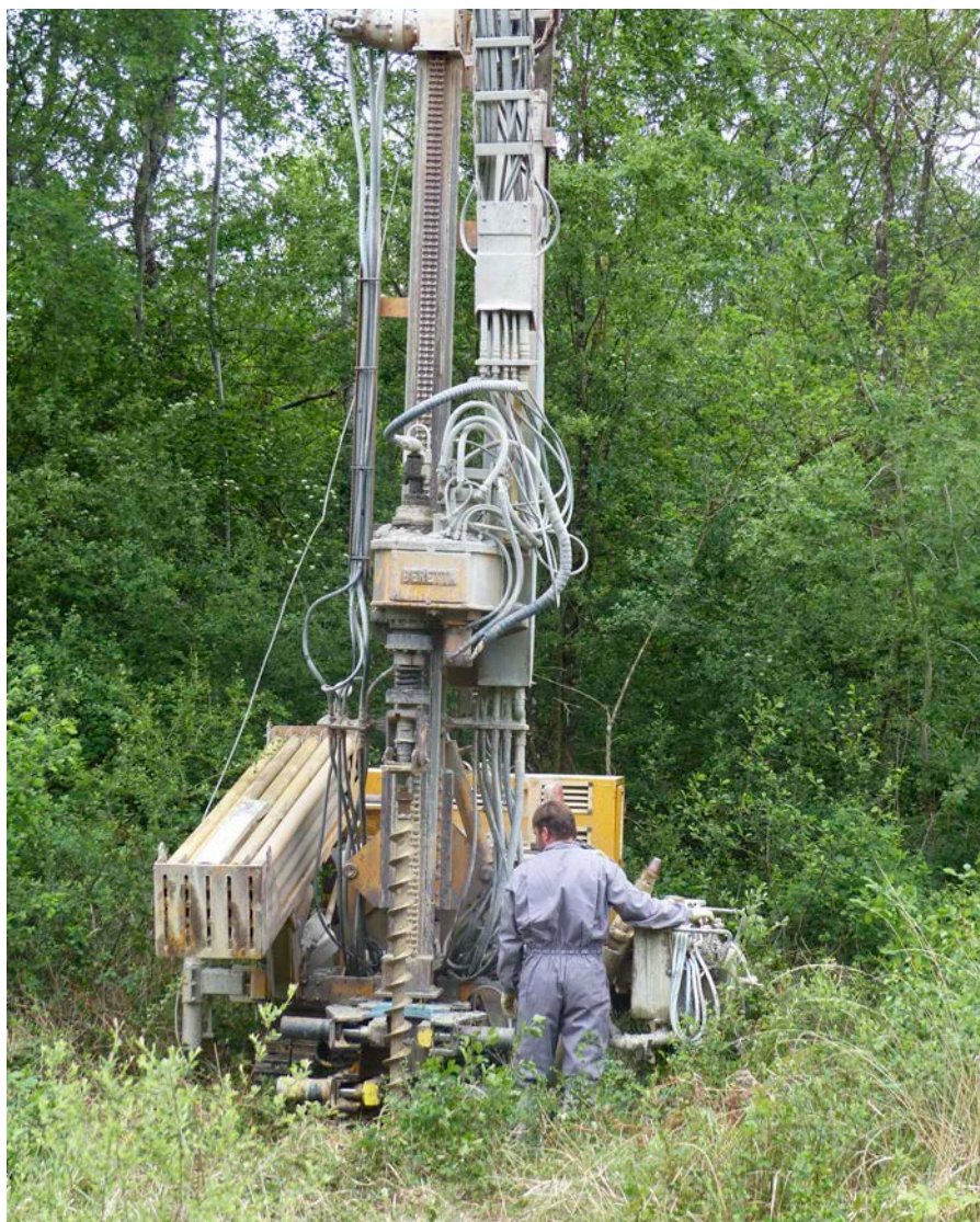
Forage dans la tourbière des Loges pour la pose de piézomètres
