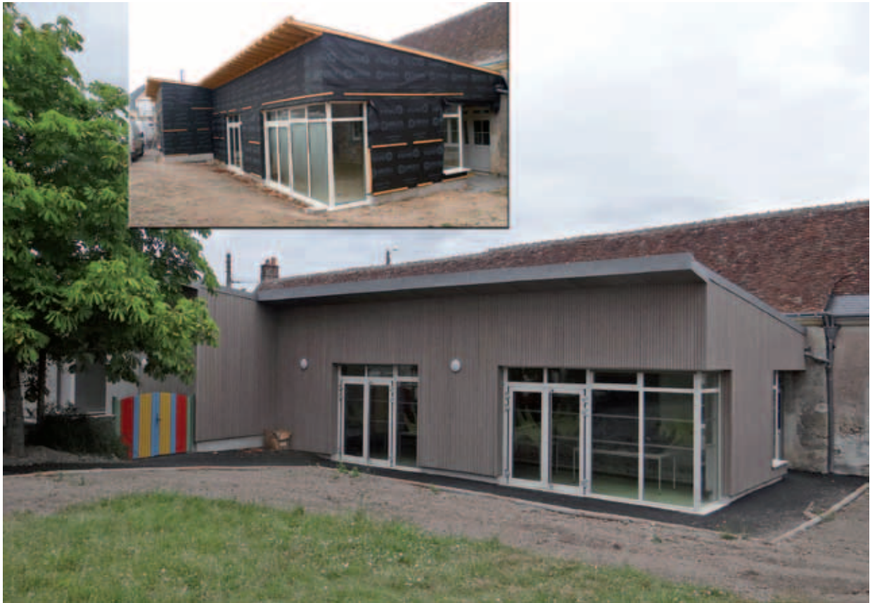
Vallères : Vue de la cantine pendant les travaux et après
