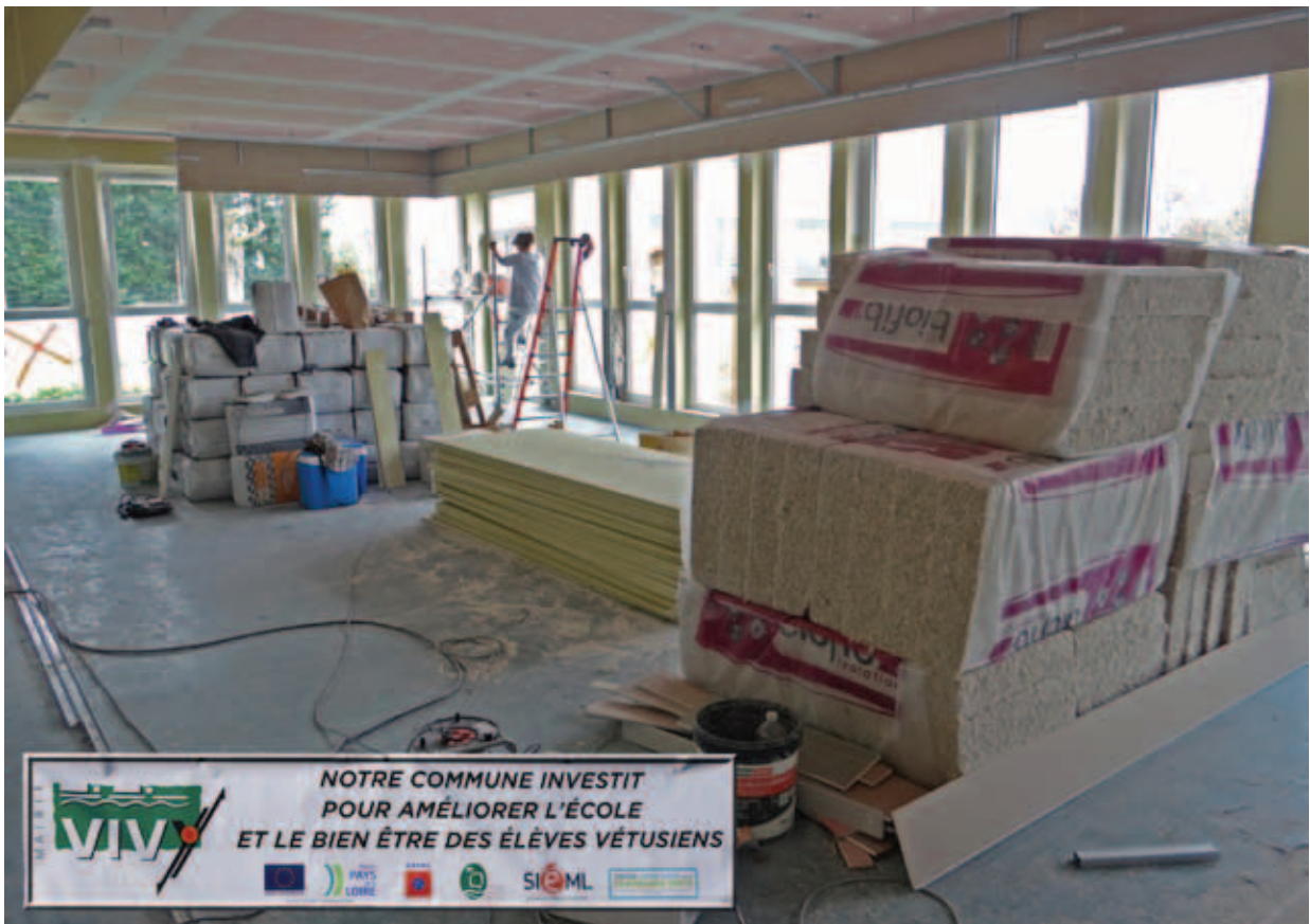
Chantier de réhabilitation du groupe scolaire à Vivy
