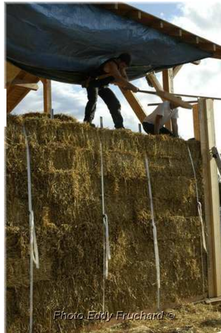
La compression des murs de paille
