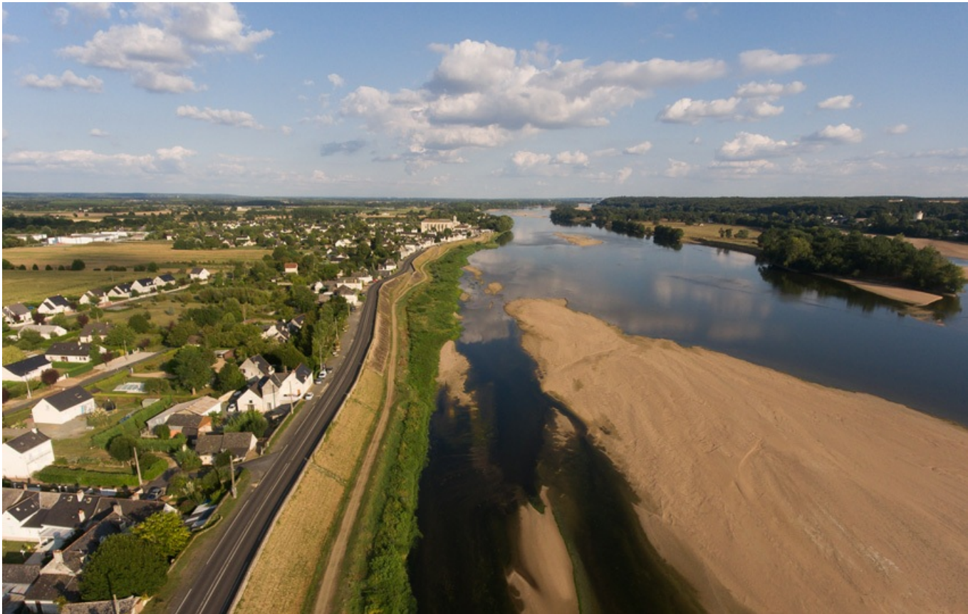
© N. Van Ingen - La levée de la Loire, au fond la commune de Saint-Clément-des-Levées
